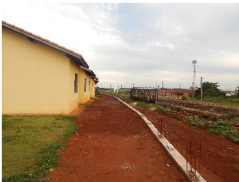
Figura 3 - O muro de arrimo pronto visto de dentro do condomínio
