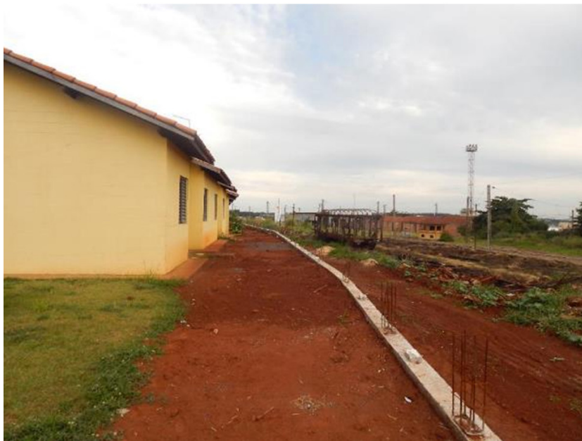
Figura 3 - O muro de arrimo pronto, visto de dentro do condomínio. p. 12
