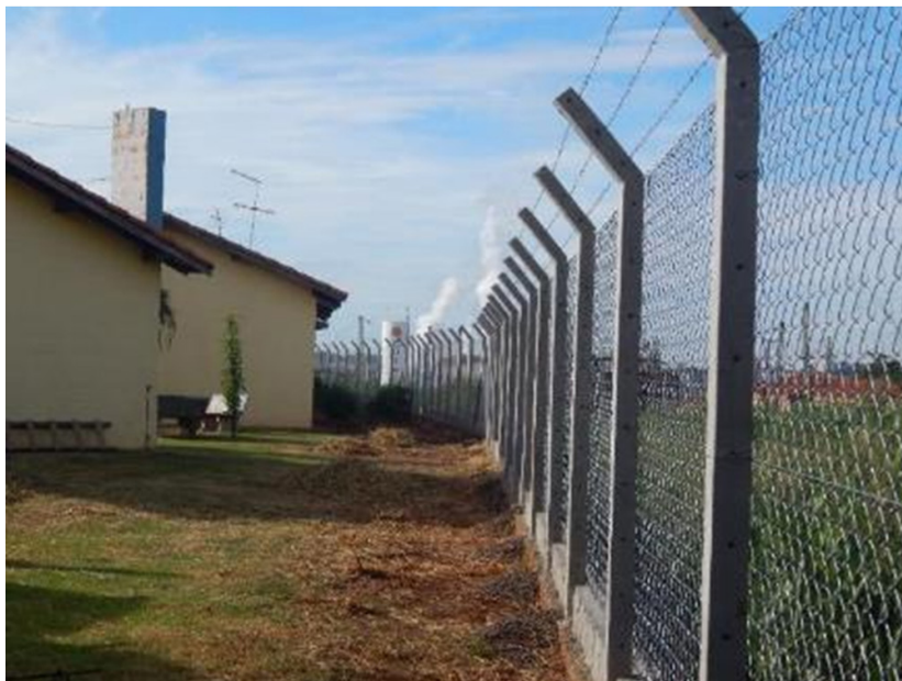
Figura 4 - O alambrado sobre o muro de arrimo
