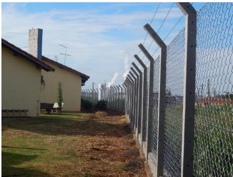
Figura 4 - O alambrado sobre o muro de arrimo. p. 14
