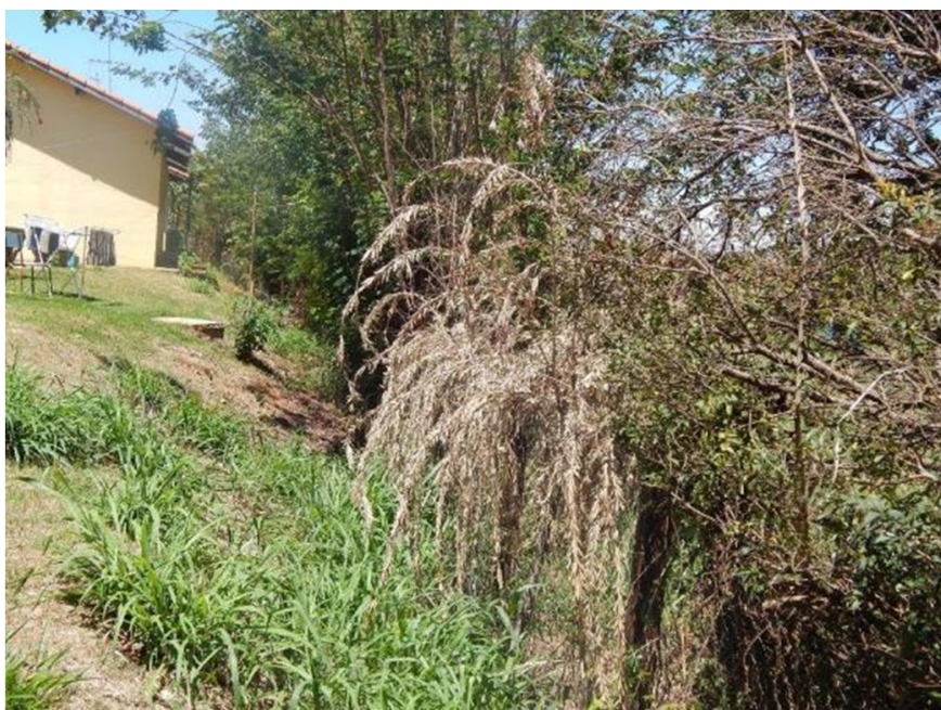
Figura 2 - O local indicado para construção do muro de arrimo visto de perto.
