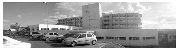
Figura 08: Foto panorâmica dos blocos B e E.
