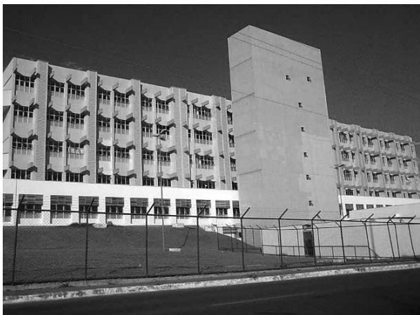
Figura 17: Bloco de internação com caixa de escadas e elevadores
