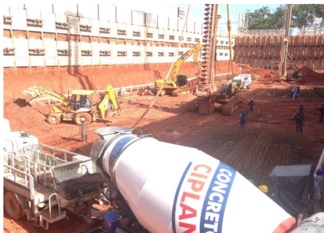
Figura 3.6 – Equipamentos utilizados durante a execução de uma estaca hélice contínua
