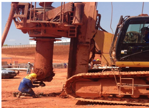
Figura 3.2 – Colocação da tampa provisória no trado da hélice
