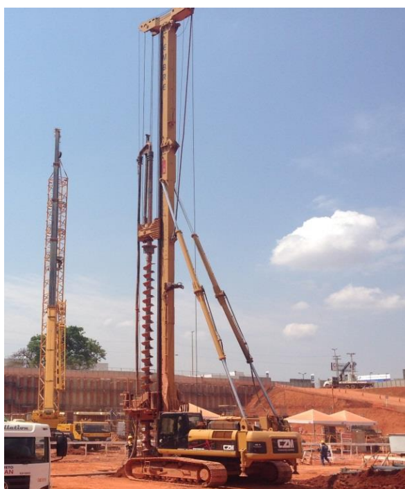
Figura 3.3 – Perfuração no terreno a partir da hélice
