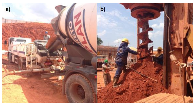
Figura 3.4 – a) Lançamento do concreto no caminhão guia; b) Concretagem com simultânea limpeza do trado.
