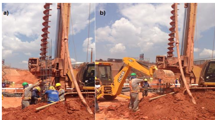
Figura 3.5 – a) Colocação da armadura manualmente; b) Com o auxílio da pá-carregadeira
