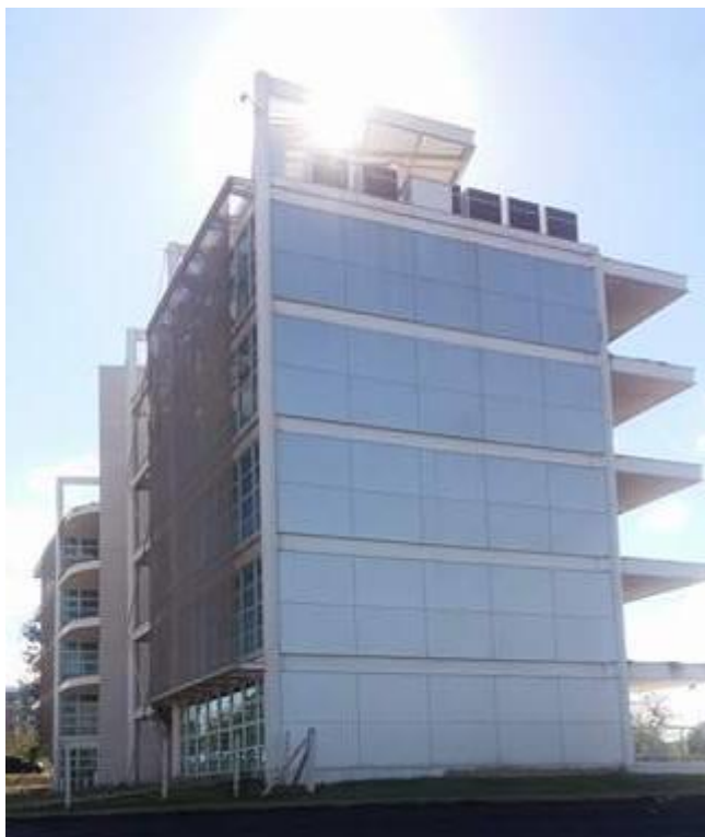
Figura 21: Fachada em alvenaria.
