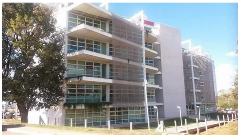
Figura 22: Estrutura metálica aparente.
