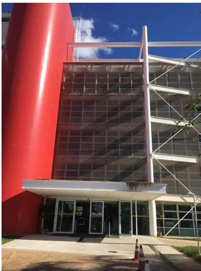
Figura 21: Estrutura metálica em contraventamento presente na fachada.
