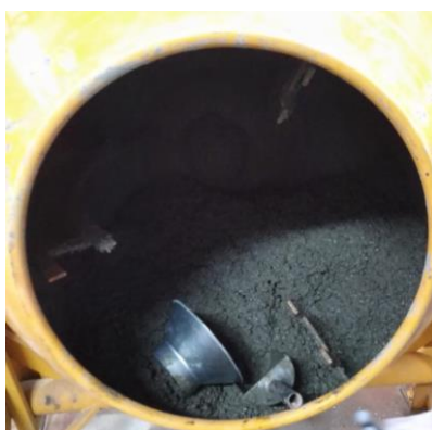
Figura 16 - Betoneira já com o concreto
