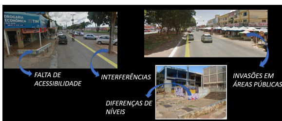
Figura 4 – Interferências e diferenças de níveis em áreas urbanas consolidadas
