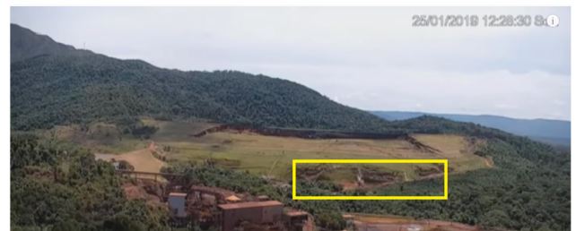
Figura 10- Segundo estágio rompimento pela base e descolamento da vertente do talude
