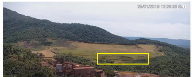
Figura 9- Primeiro estágio de deformação que precede o rompimento pela vertente do leito
